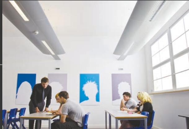
Aufrechterhaltene Helligkeit, in diesem Beispiel 300 Lux, Themenbeleuchtung, falls verwendet, schaltet sich aus. Maximaler Energiesparmodus.
